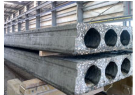
Vista de la superficie de alta calidad de los perfiles laterales de una placa alveolar de 900 mm de anchura.
